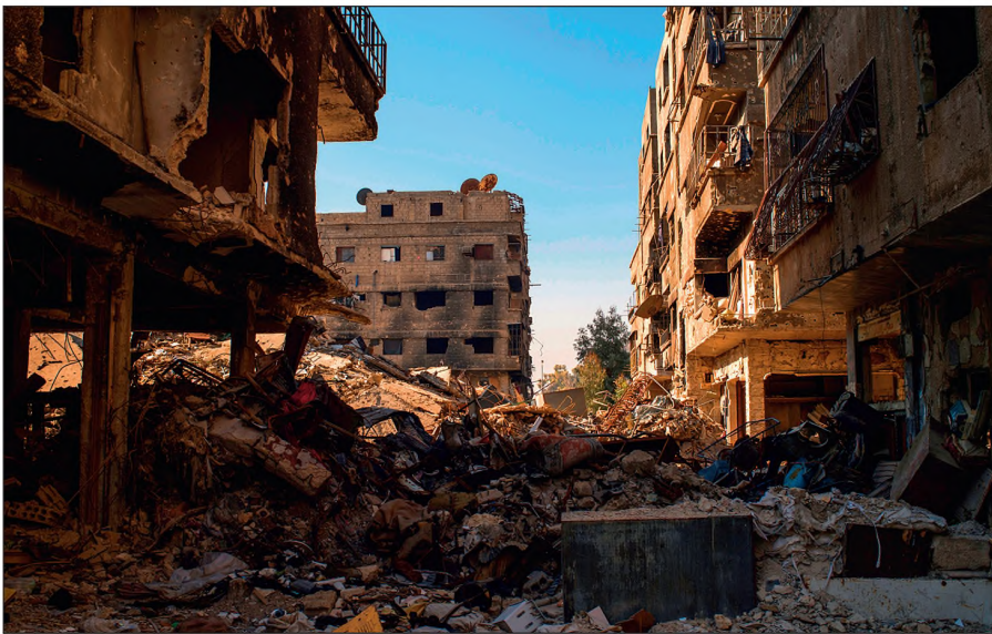
Разрушенный боевиками ИГИЛ Дамаск.
